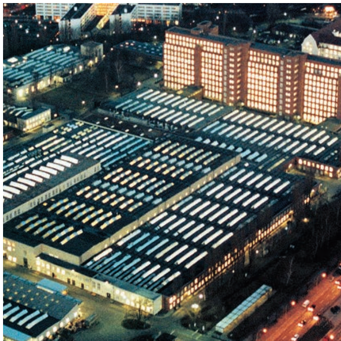
Fábrica de Interruptores Schaltwerk Berlín
